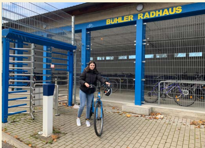
Das Fahrradparkhaus am Bühler Bahnhof mit 120 sicheren und witterungsgeschützten Fahrradabstellplätzen.
